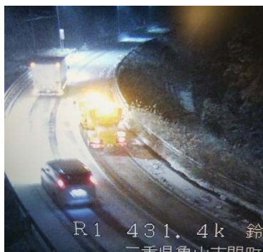
凍結防止剤散布作業
