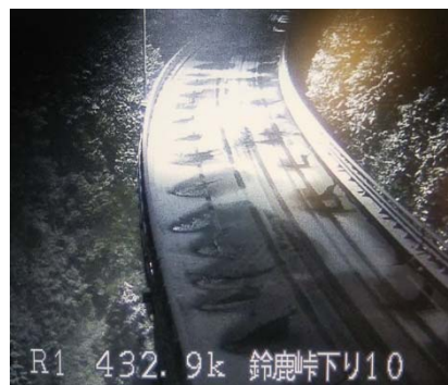
消雪パイプによる散水
