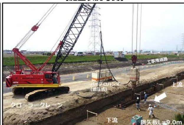
【施工状況写真】
