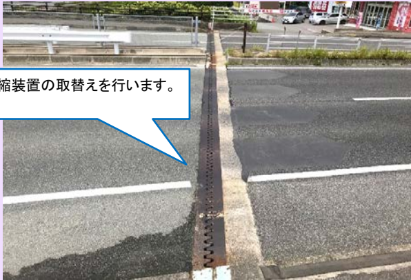
伸縮継手工（施工前）
