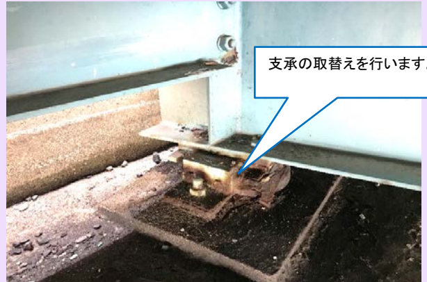
橋梁補修工（支承取替 施工前）
