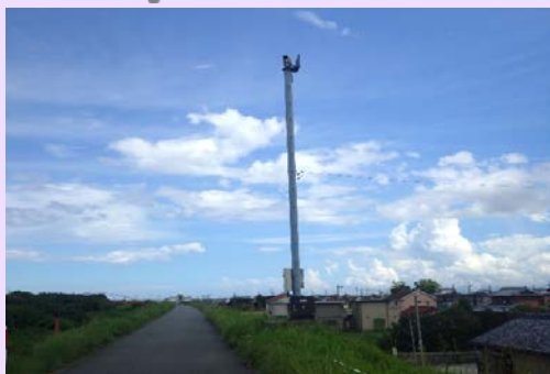
雲出橋観測所CCTV
