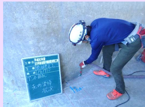
橋脚巻立て工 削孔穴清掃状況
