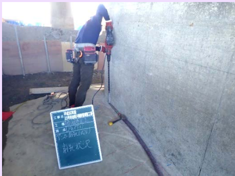
橋脚巻立て工 削孔状況
