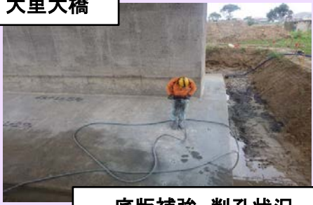
底版補強 削孔状況
