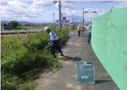
国道23号の除草作業
