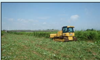
令和元年 7月末（施工中）
