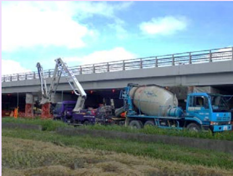
橋梁付属物工 コンクリート打設状況
