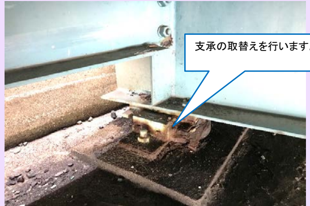
橋梁補修工（支承取替 施工前）
