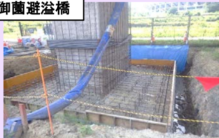
底版補強鉄筋組立状況
