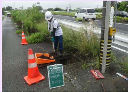
排水施設の清掃作業
