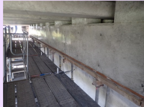
橋梁付属物工 コンクリート打設完了
