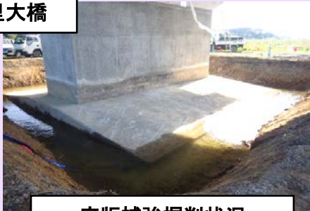
底版補強掘削状況
