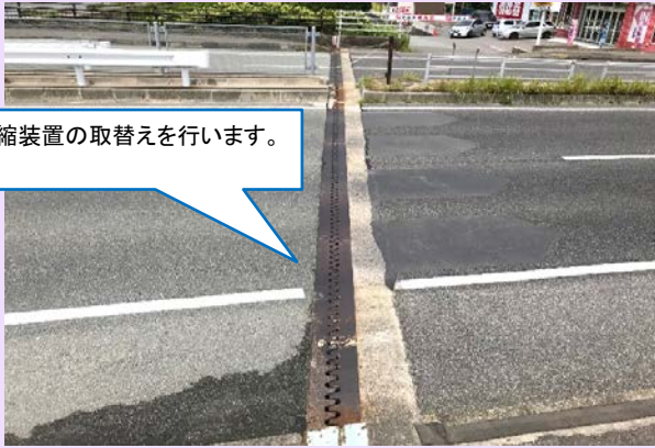
伸縮継手工（施工前）
