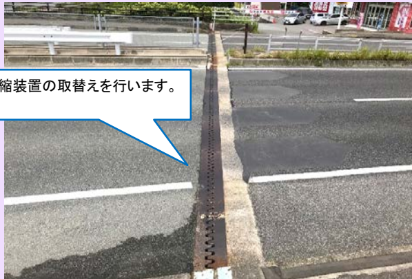
伸縮継手工（施工前）
