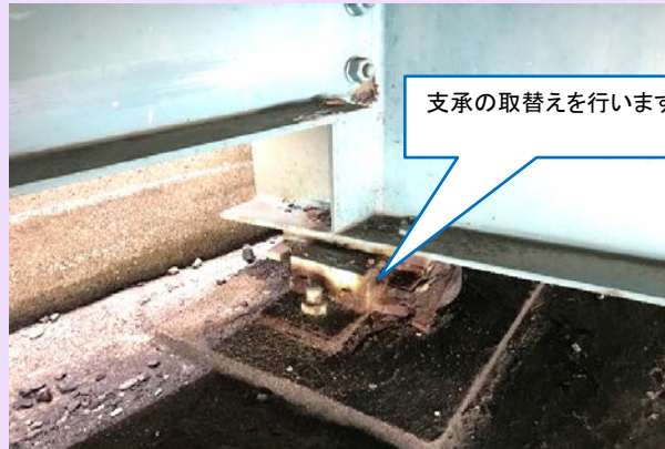
橋梁補修工（支承取替 施工前）
