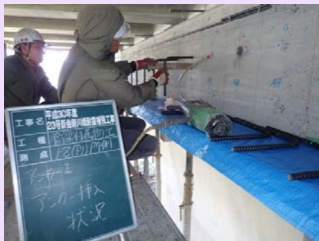
橋梁付属物工 アンカー挿入状況
