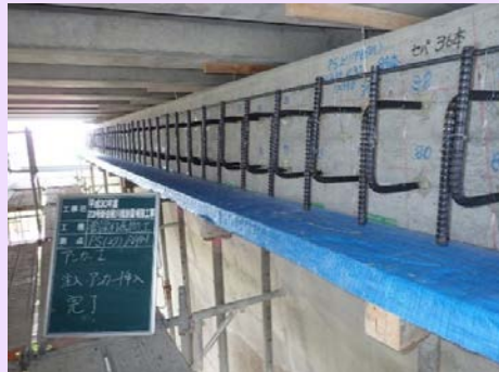
橋梁付属物工 アンカー設置完了
