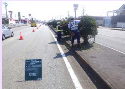
国道23号の剪定作業
