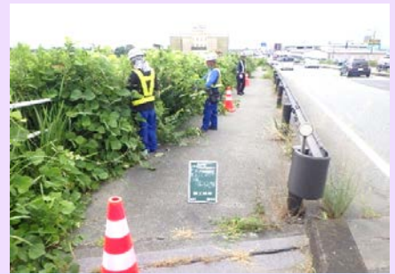
通行に支障のある繁茂した雑草の除去
