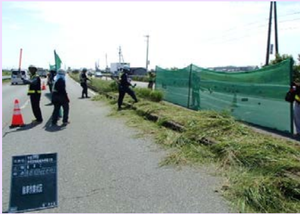
国道23号の除草作業
