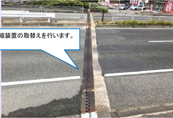
伸縮継手工（施工前）
