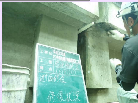
橋梁補修 断面修復状況
