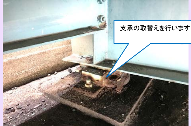
橋梁補修工（支承取替 施工前）
