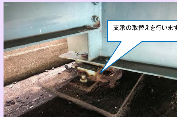
橋梁補修工 (支承取替 施工前)
