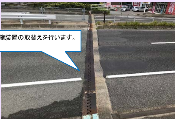
伸縮継手工 (施工前)
