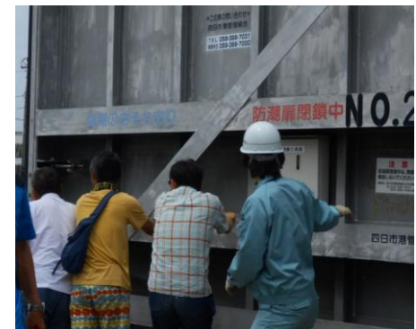
防潮扉開閉訓練の様子
