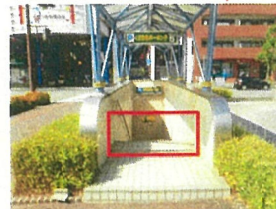
5番階段(防水板設置)
