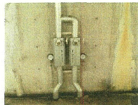
雨水ポンプ設置(8カ所)
