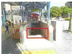
1番階段(防水板設置)
