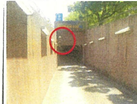
入口監視カメラ
