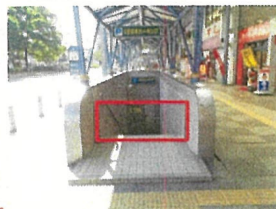
2番階段(防水板設置)
