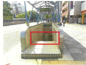
3番階段(防水板設置)
