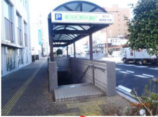
8番階段(防水板設置)
