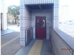
エレベーター(防水板)
