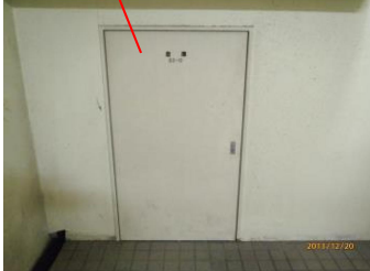
土嚢倉庫 (地下1階. 2階倉庫)
