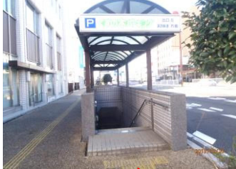
6番階段(防水板設置)
