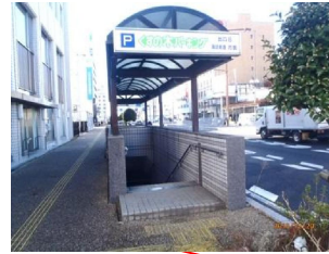
8番階段(防水板設置)
