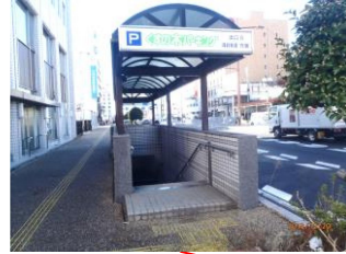
8番階段(防水板設置)
