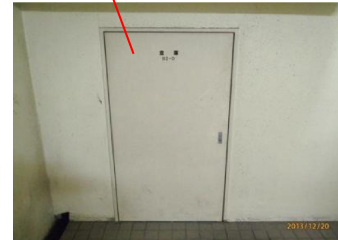
土嚢倉庫(地下1階. 2階倉庫)
