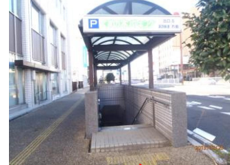
6番階段(防水板設置)
