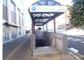
6番階段(防水板設置)
