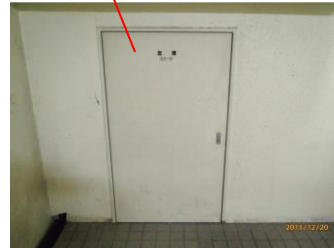
土嚢倉庫(地下1階. 2階倉庫)
