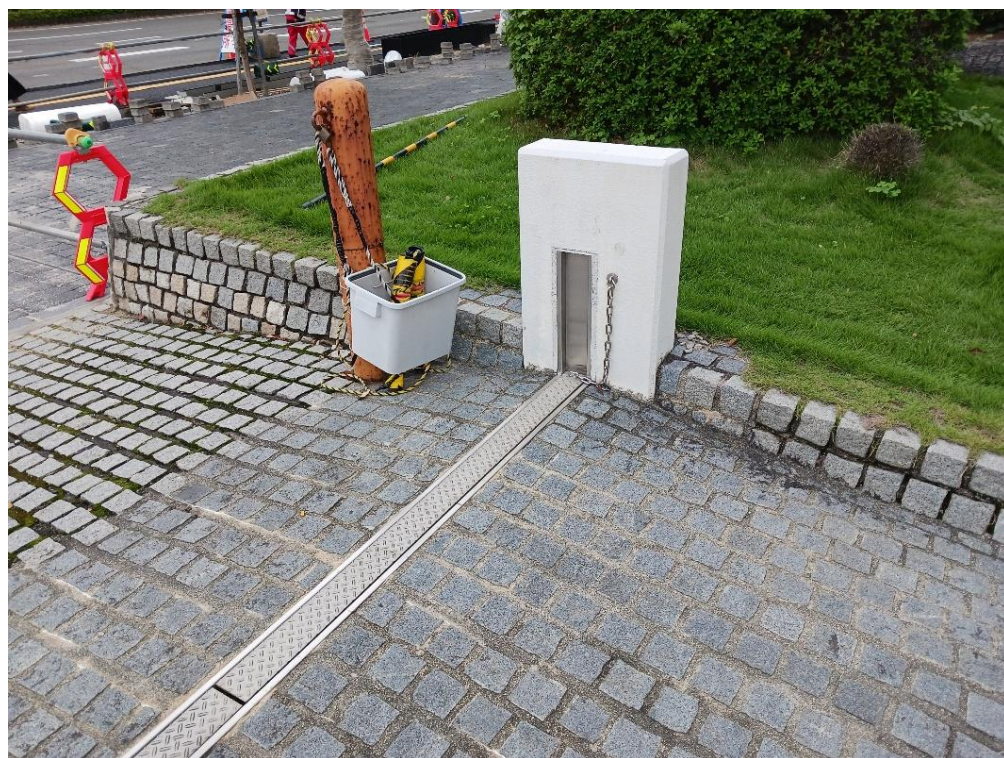
車両用出口のかさ上げ ※車道より約50cm (四日市市役所南側スロープ)
