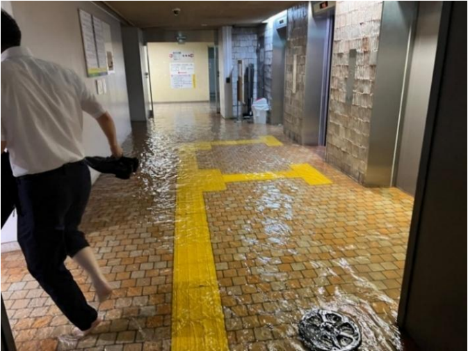
市役所地下の浸水状況
