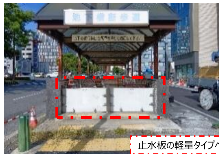
止水板を壁面収納へ変更
