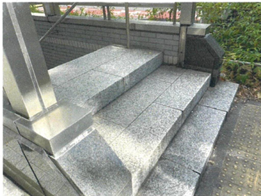
入口階段を2段かさ上げ (名古屋市内地下街の取り組み)
