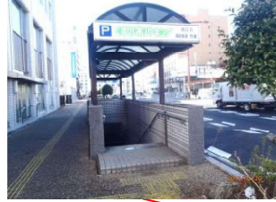
8番階段(防水板設置)
