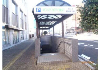
6番階段(防水板設置)
