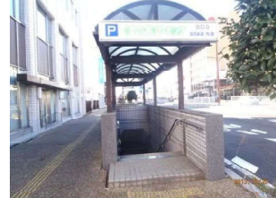
6番階段(防水板設置)
