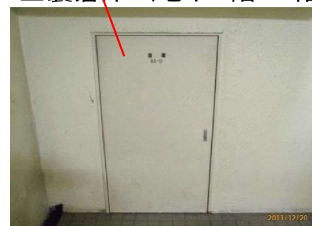
土嚢倉庫(地下1階. 2階倉庫)
