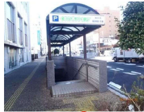
8番階段(防水板設置)
