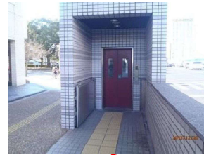
エレベーター(防水板)
