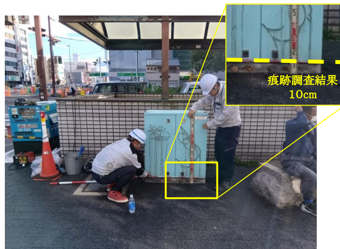
痕跡調査(西側) (9/26: 出入口から約16mの側面のボックス)
