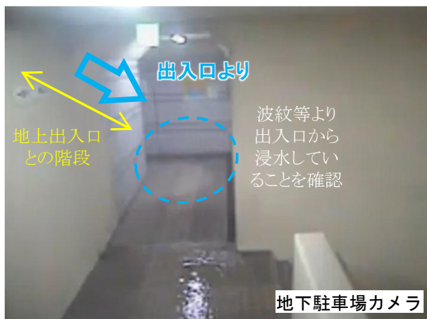
地下1階への浸水開始状況
