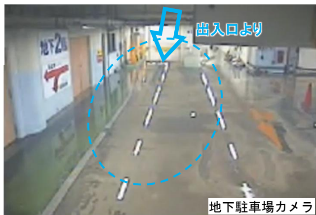
地下2階の浸水開始状況
