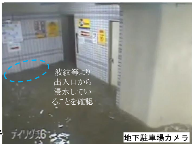
地下1階への浸水開始状況
