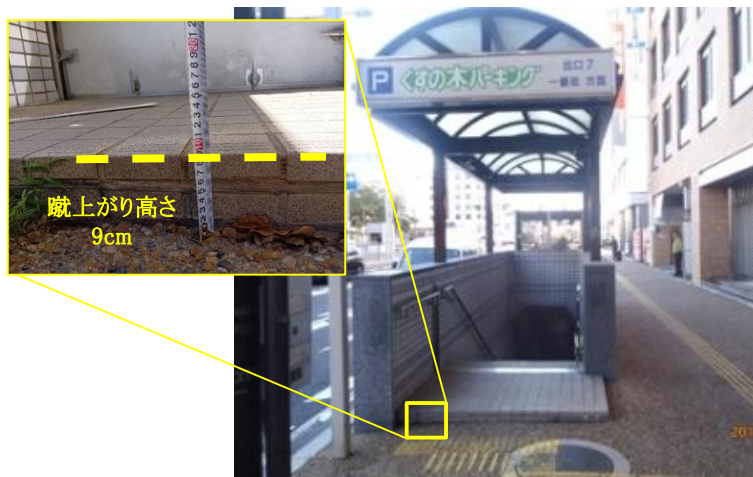
出入口の状況(平時)
