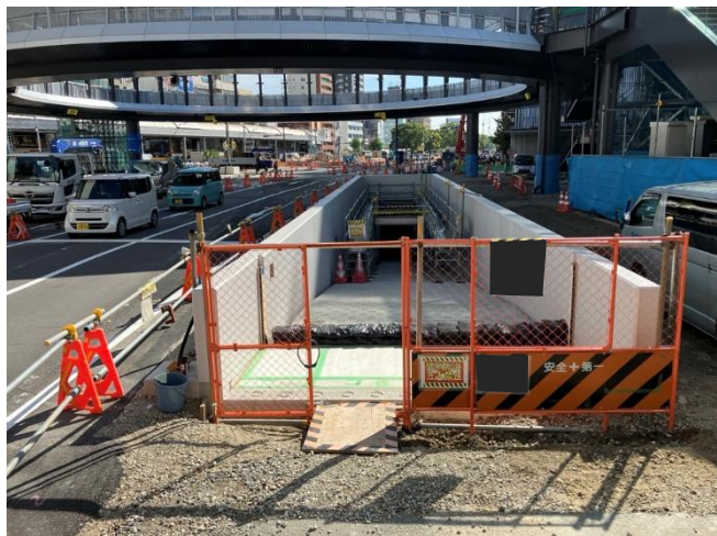
工事用出入口の状況(10/8)
