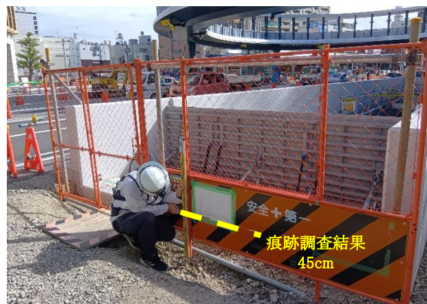
痕跡調査 (10/10:出入口の工事用フェンス)
