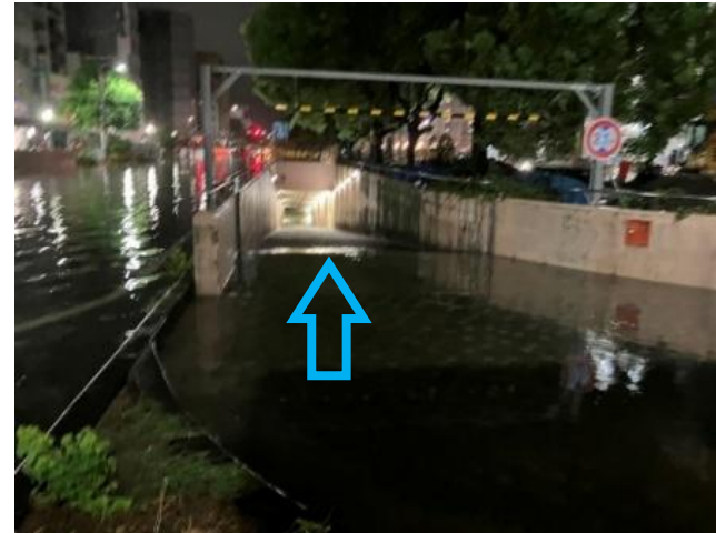
地上の冠水状況(9/13 0時頃)
