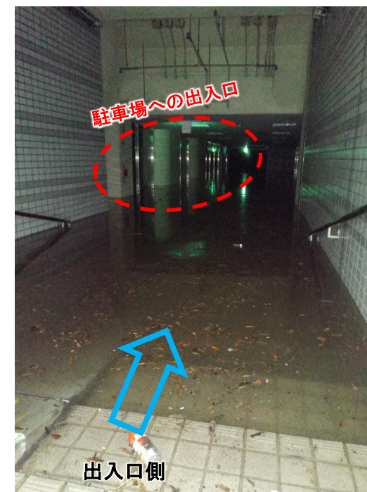
西側出入口(地下1階)の 冠水状況(9/13)
