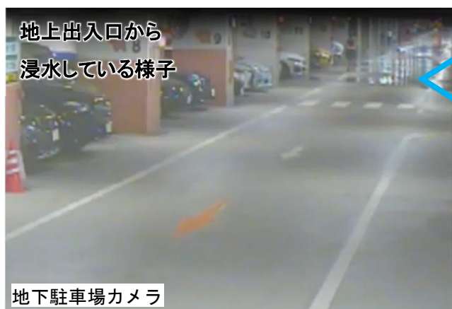
地下1階への浸水開始状況
