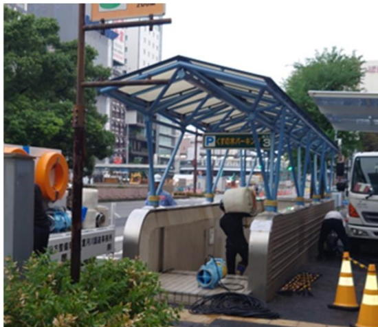
出入口の状況(平時)
