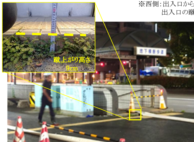
出入口の状況(西側)
