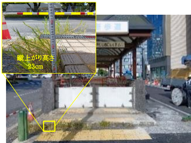
出入口の状況(東側)
