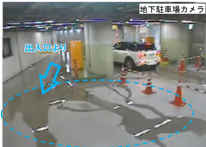
地下1階への浸水開始状況
