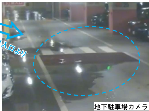
地下1階への浸水開始状況
