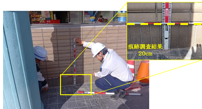
痕跡調査 (9/26: 出入口から約6mの側壁)
