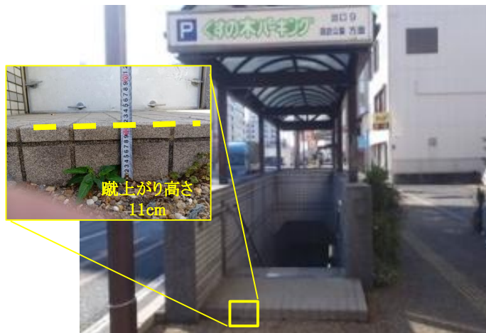
出入口の状況(平時)
