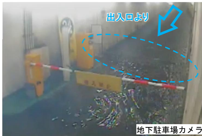
地下2階の浸水開始状況
