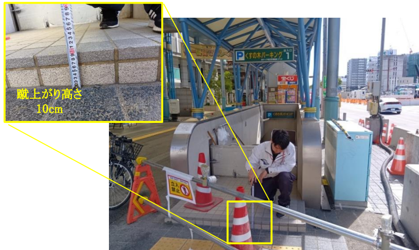
出入口の状況(平時)
