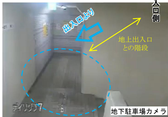
地下1階の浸水開始状況
