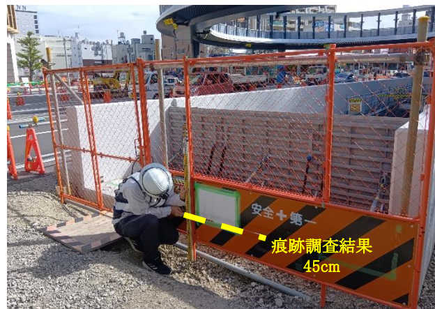
痕跡調査 (10/10:出入口の工事用フェンス)
