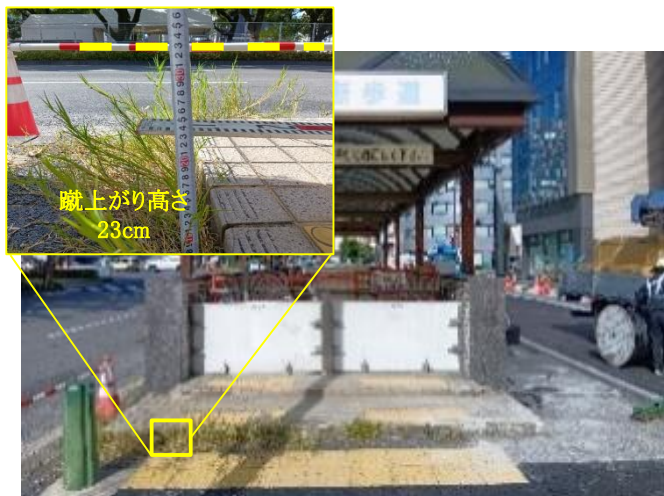
出入口の状況(東側)
