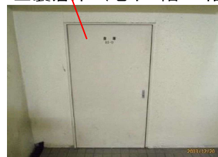
土嚢倉庫(地下1階. 2階倉庫)
