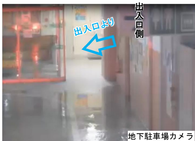
地下1階への浸水開始状況
