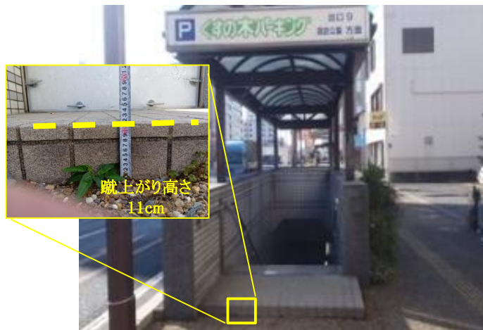
出入口の状況(平時)
