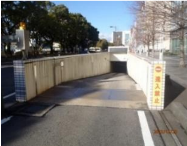
車両出口の状況(平時)
