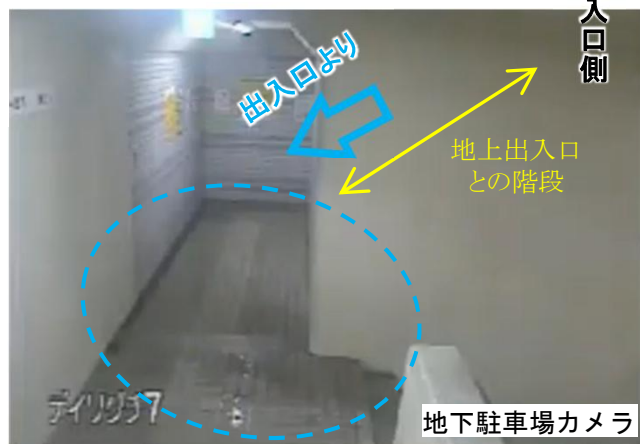
地下1階の浸水開始状況
