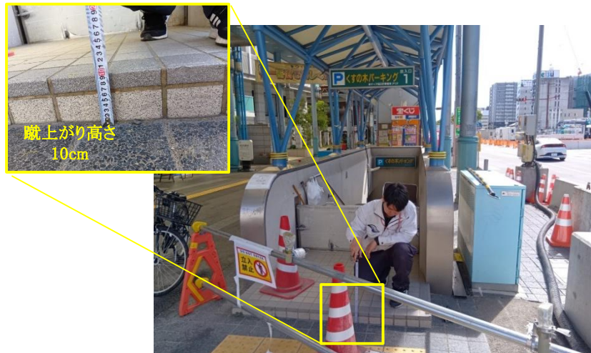
出入口の状況(平時)
