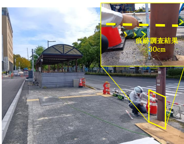
痕跡調査(東側) (10/2: 出入口から約26mの支柱)
