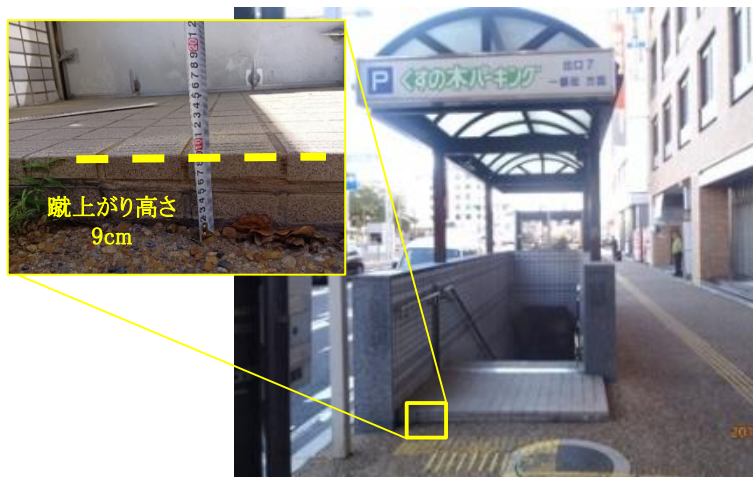
出入口の状況(平時)
