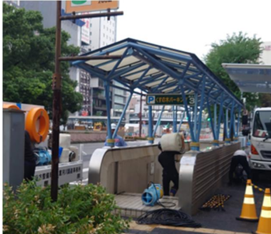
出入口の状況(平時)
