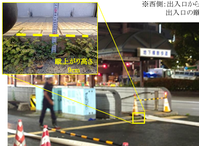
出入口の状況(西側)
