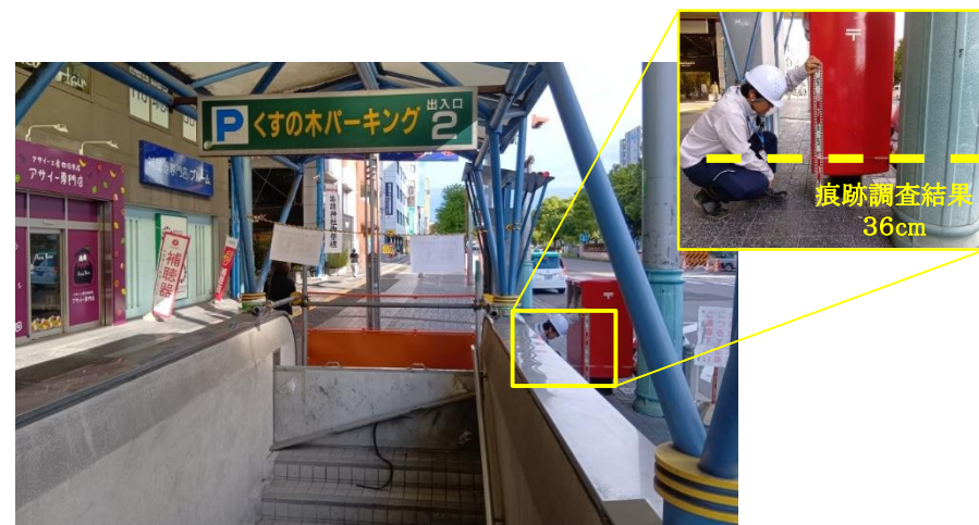
痕跡調査 (9/26: 出入口から約3mの郵便ポスト)
