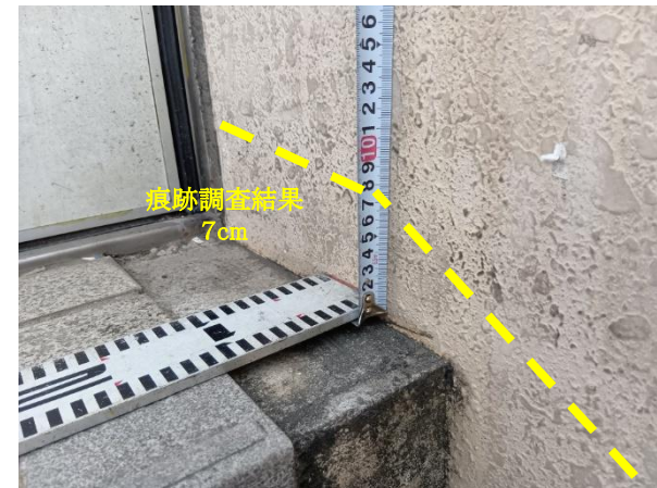
痕跡調査 (10/2:出入口の側壁)
