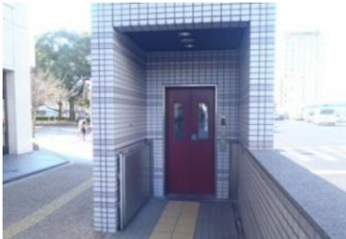
エレベーターの状況(平時)
