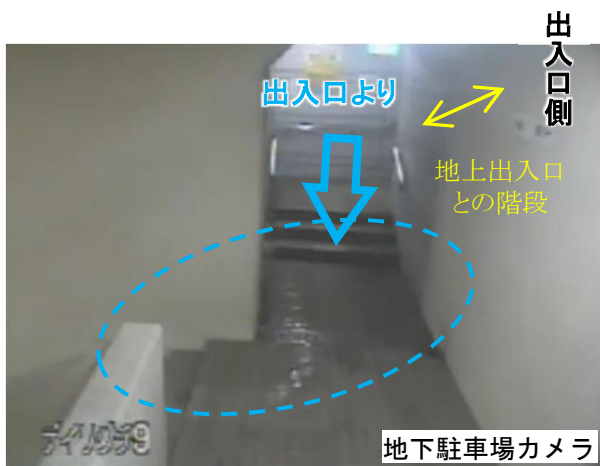
地下1階への浸水開始状況
