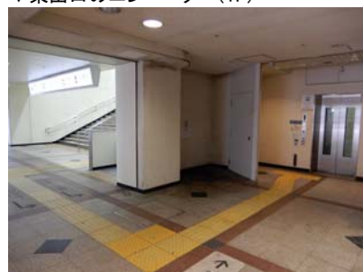
▼東出口のエレベーター(1F)
