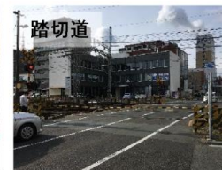
踏切道 歩道がなく危険で、遮断時間も長い
