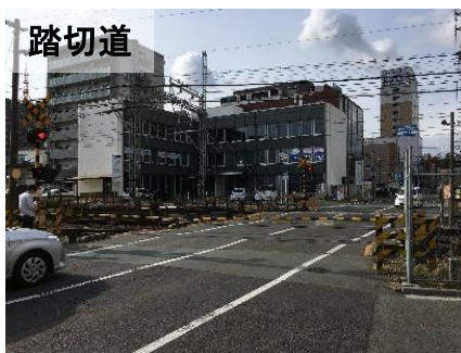
歩道がなく危険で、遮断時間も長い
