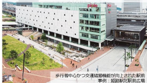
歩行者中心かつ交通結節点機能が向上された駅前 事例：姫路駅北駅前広場
