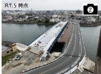
▲ 新橋脚 躯体建造作業
