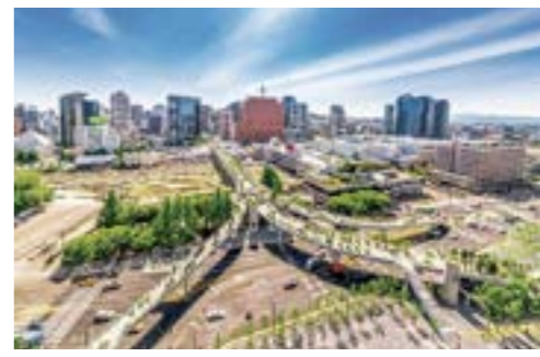
高架橋の施設緑化の事例 (ソウル, 韓国)
