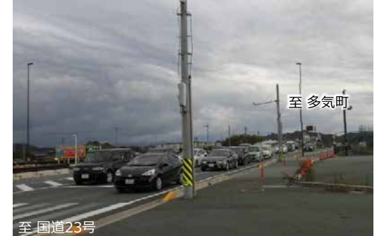
上川町交差点（国道42号松阪多気バイパス：上り）
