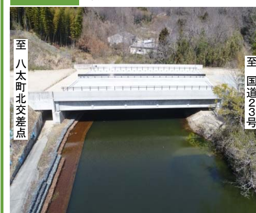
写真③ 御前池PC橋上部工完成
