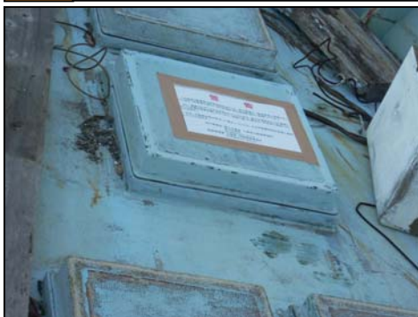
① 撤去警告書の掲示 (H21.10.15)
