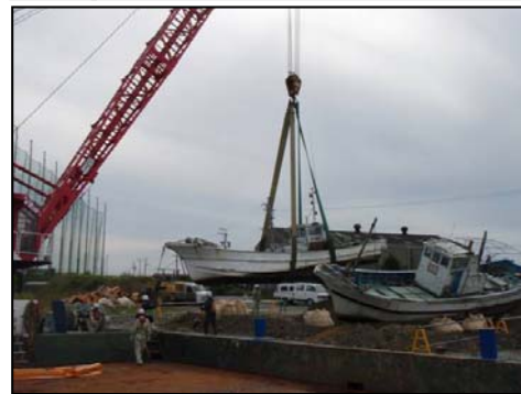
④ 強制的な撤去措置 (H22.5.28)
