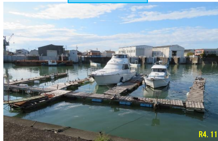
防潮水門下流左岸
