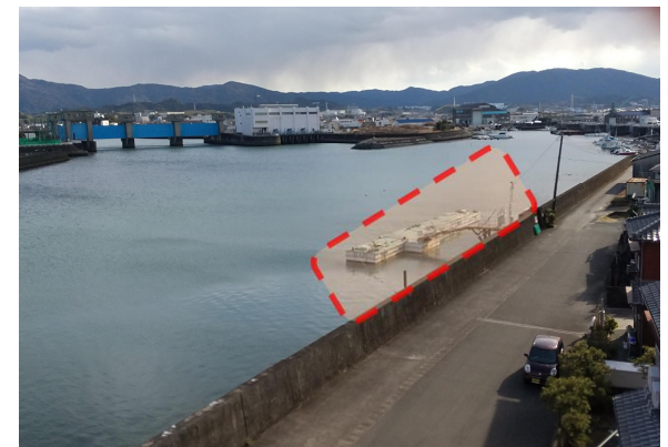
一色大橋上流左岸 (係留希望箇所)
