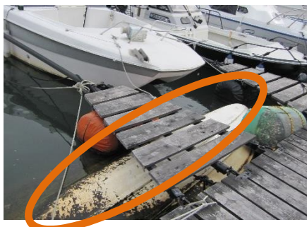
一色大橋下流左岸【廃船撤去】
