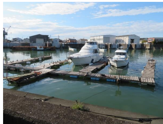
防潮水門下流左岸 (係留希望場所)
