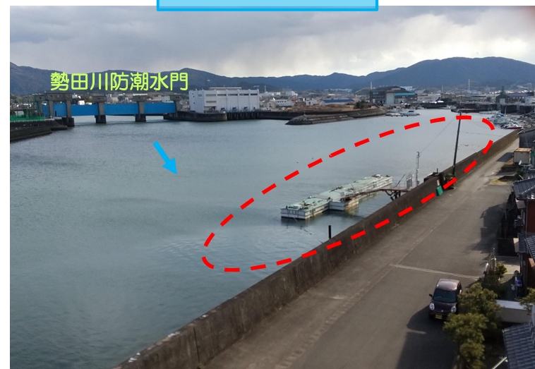
一色大橋上流左岸
