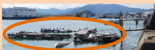
一色大橋上流左岸【栈橋撤去】
