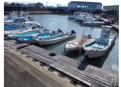
当該係留施設の様子 (平成28年6月撮影)
