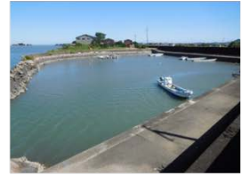
一色町物揚場施設
