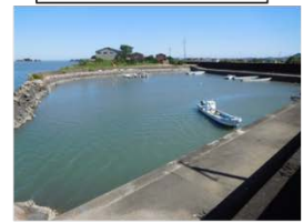
一色町物揚場施設
