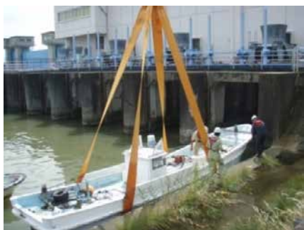
③撤去作業
