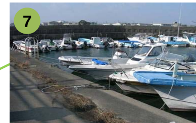
一色町地先船溜まり
