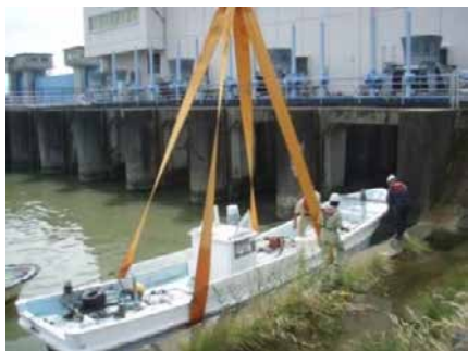
③撤去作業
