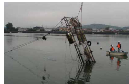
栈橋の撤去後状況
