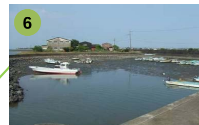
一色町物揚場施設
