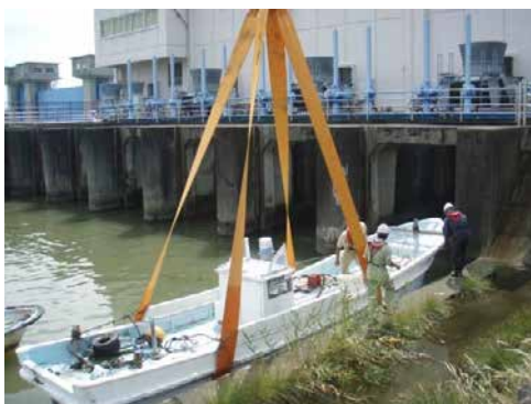
③撤去作業
