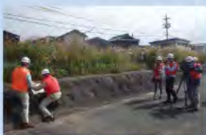
貼付作業時の取材
