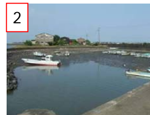
2 一色町物揚場施設
