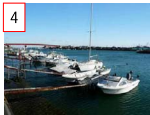
4 防潮水門下流左岸
