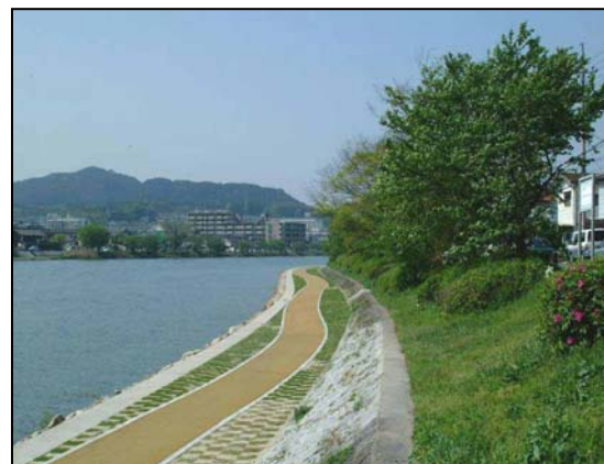
施工事例: 瀬田川
