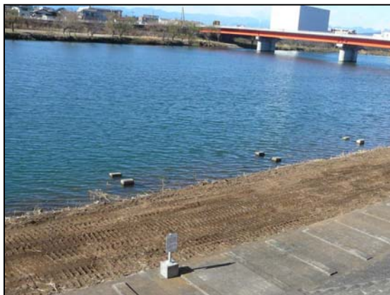
施工事例: 狩野川
