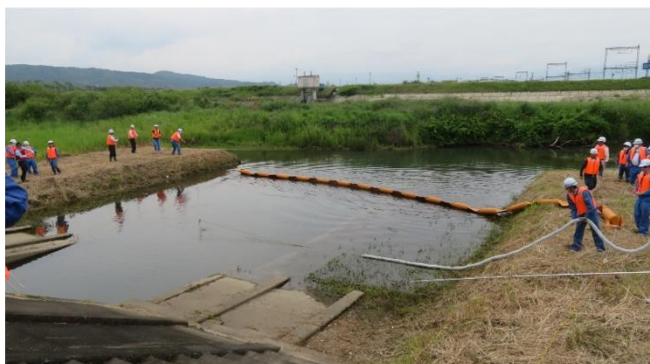
オイルフェンスの展張実践
