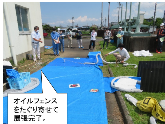
投げたロープをオイルフェンスに結び展張
