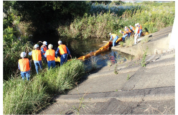
吸着マットの設置、撤去
