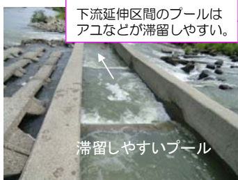
図-3.3 (4) 堰・頭首工の魚道及び河道状況の課題（櫛田可動堰）
