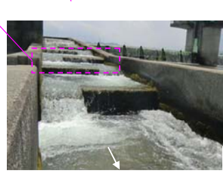
図-3.3 (4) 堰・頭首工の魚道及び河道状況の課題（櫛田可動堰）
