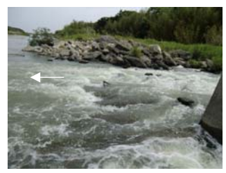
魚道入り口付近には、用水の余水放流により流速2m/sを超える速い流れがあり、魚類の遡上が困難（遡上の障害）。
