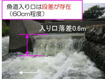
図-3.3 (4) 堰・頭首工の魚道及び河道状況の課題（櫛田可動堰）
