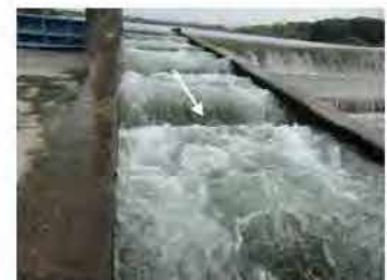
下流延伸区間では、頭首工（水叩き）からの越水が魚道内に流入し、流速が速くなっている。
