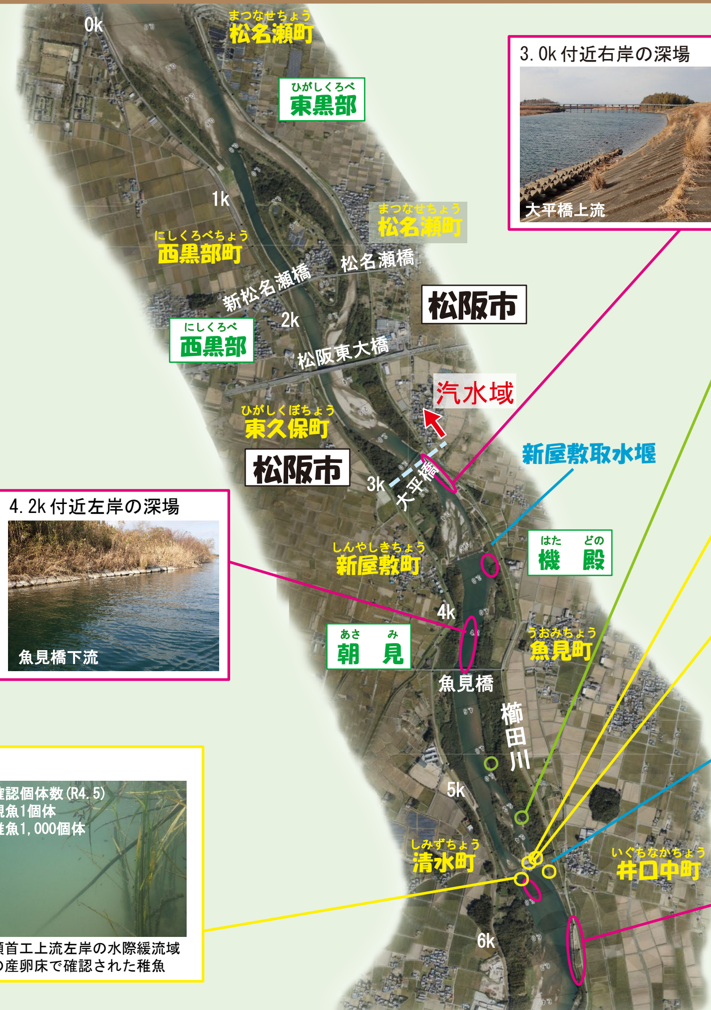
櫛田第二頭首工上流
