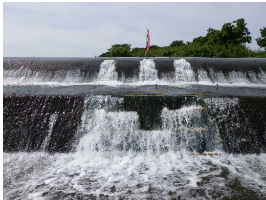
ネット型仮設魚道
