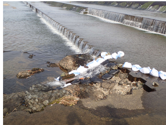
袋詰め玉石による段差解消
