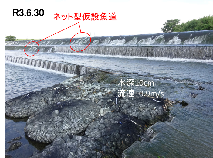
袋詰め玉石による段差解消
