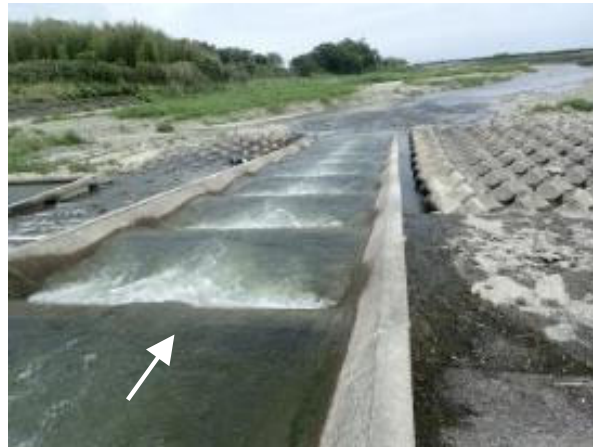
新設：台形断面式魚道
